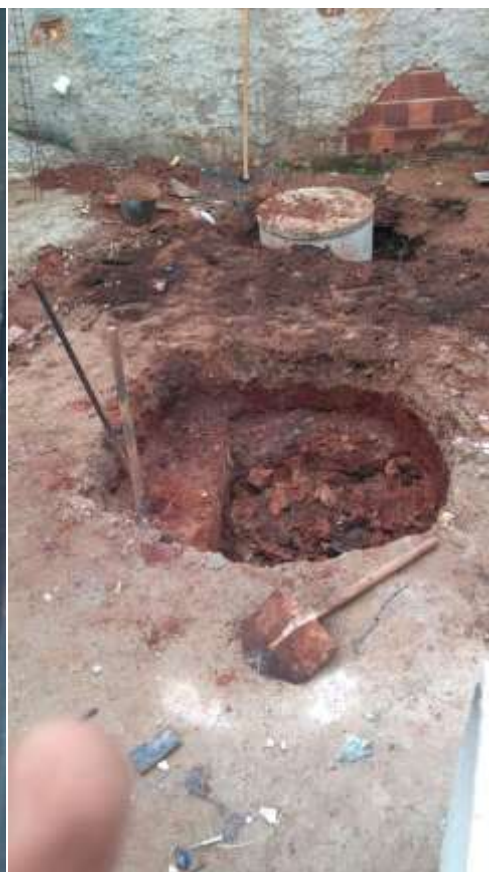
Fig. 9 - Ampliação da fossa
