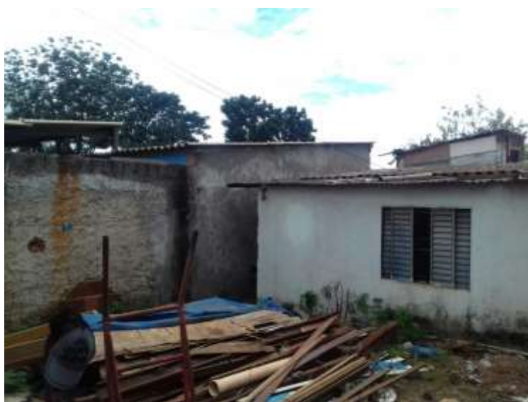
Fig. 3 – Casa existente no terreno novo
