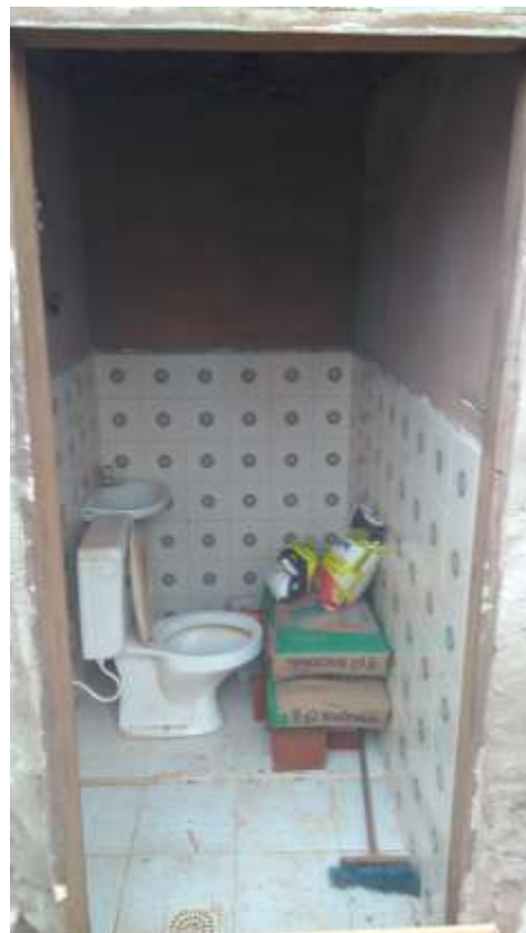
Fig. 7 - Reforma no banheiro do terreno novo
