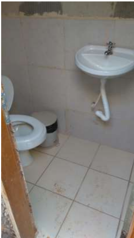
Fig. 6 - Reforma no banheiro do terreno antigo
