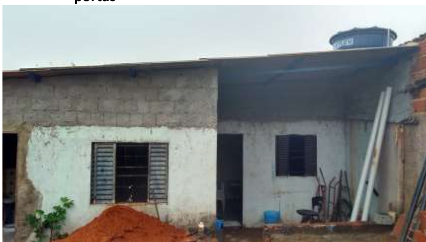
Fig. 10 – Aumento do pé direito e mudança no caimento do telhado
